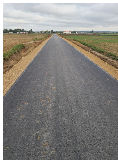
Rys. 17 Fragment drogi po remoncie.
