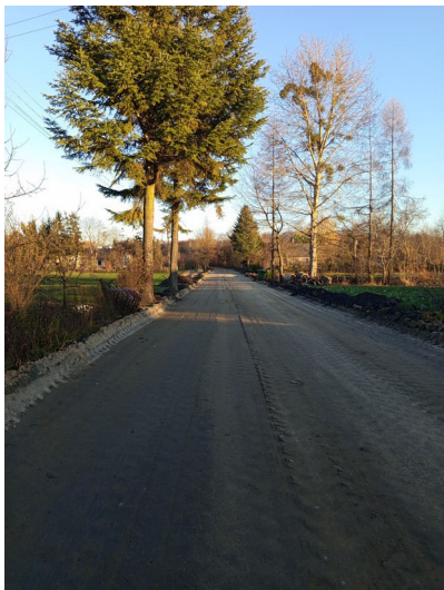
Rys. 13 Fragment budowy drogi Terebiń.
