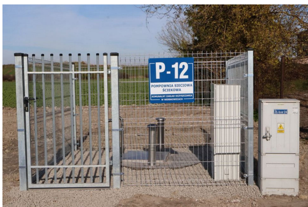
Rys. 8 Przepompownia ścieków.
