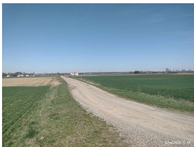
Rys. 16 Fragment drogi przed remontem.
