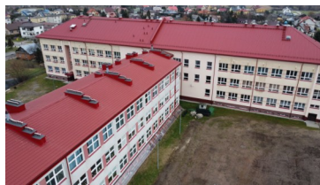
Przebudowa ZSP w Werbkowicach Wartość: ponad 5 mln zł
