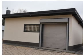
Budowa budynku gospodarczego przy UG Wartość: ok. 340 tys. zł
