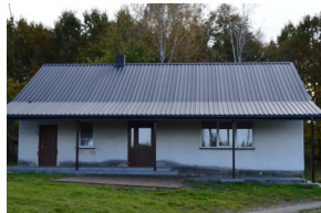
Remont dachu świetlicy w Adelinie Wartość: ok. 30 tys. zł
