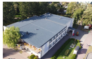
Remont dachu GOK w Werbkowicach Wartość ok. 600 tys. zł
